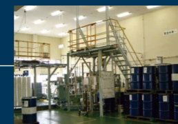
一般取扱所(小分け室)
