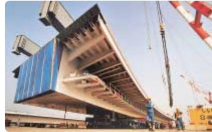
重量物輸送専用車「ユニットドーリ」で110mのレインボーブリッジ橋桁輸送（1992年）
