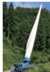
風力発電設備ブレード起立装置
