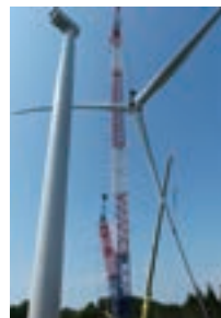
風力発電建設風景
