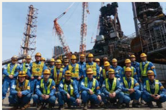
八幡製鐵所戸畑第4高炉の改修作業
